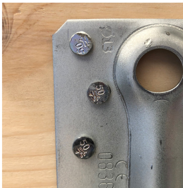
Stempler på beslagene samt længdeidentifikation på hovedet af sømmet gør det let at kontrollere samlingen efter installationen.
